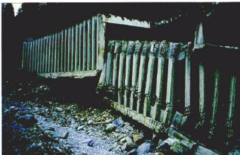
Figura 6.4 Galleria paravalanghe realizzata in fregio all'argine crollata nel corso di un'alluvione
