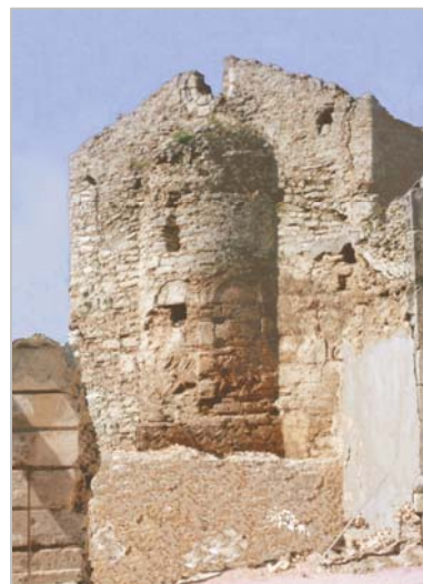
fig.2 Facciata Est della Chiesa
