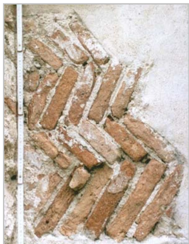
Fig.6 Muratura a "spina di pesce" nella Cattedrale di Gerace -RC
