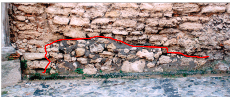
fig. 3 Integrazioni e tamponamenti dei vuoti presenti nella fondazione della facciata Nord (USM 100)
