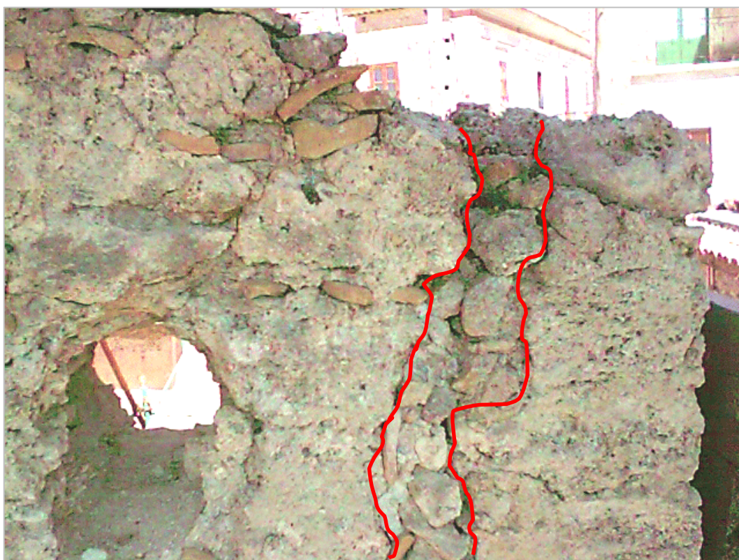
fig. 1 Risarcitura di una lesione presente nello spigolo Nord-Est della Chiesa di S. Teodoro-Annunziatella
