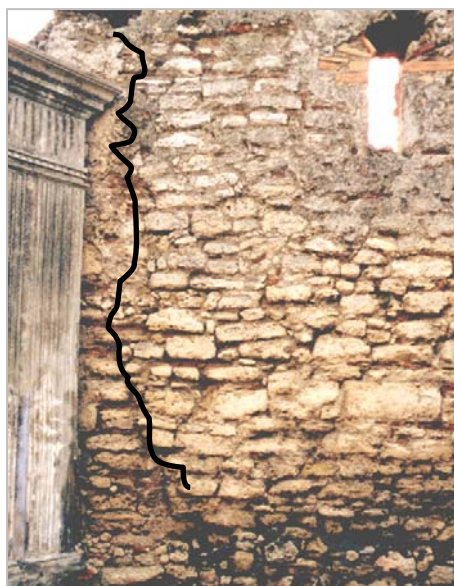
fig. 2 Interfaccia fra murature diverse (USC 102, 103, 104)
