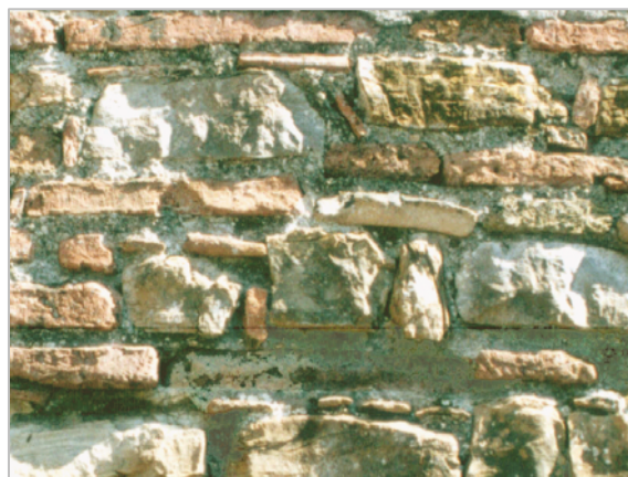
fig.4 Muratura a cloisonné. Parete sud dell’abbazia di S. Maria di Tridetti - Staiti (RC)
