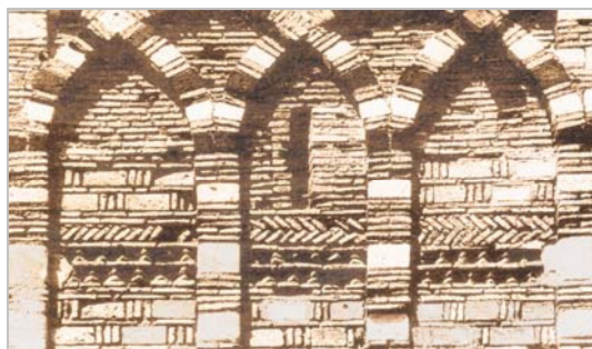
Fig.5 Fascia di muratura a "spina di pesce" nell'abside della chiesa dei SS. Pietro e Paolo, a Forza D'Agrò -ME
