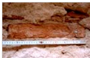
Fig.8 Esempi di mattoni di reimpiego nella chiesa di S. Teodoro-Annunziata di Gerace
