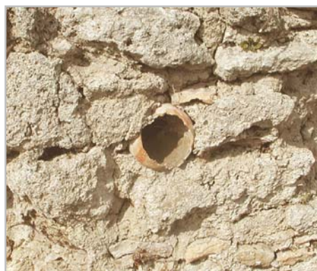
fig.13 Vasetto ubicato nella parete Sud
