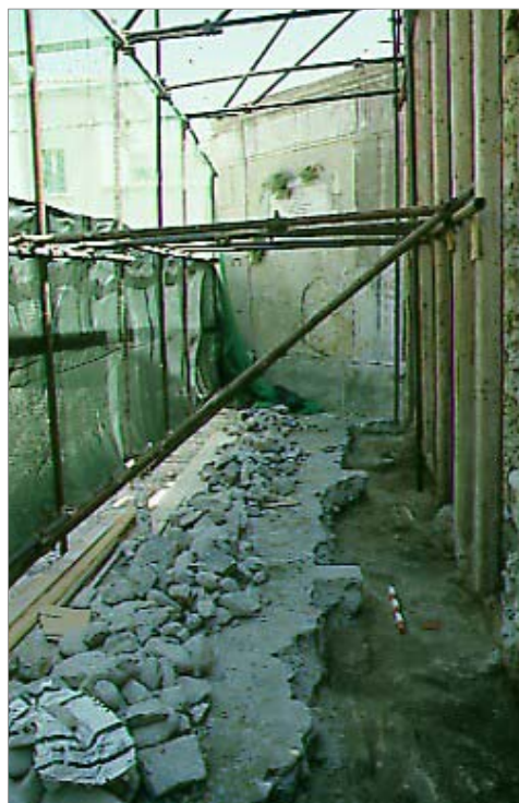
fig.1 Scavi sulla parete settentrionale
